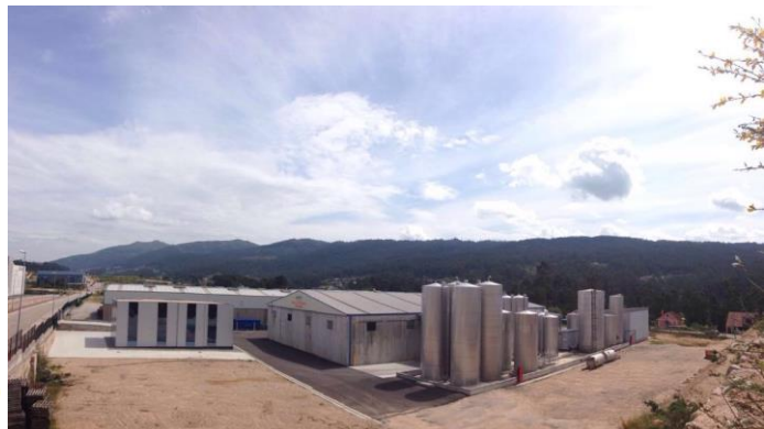
Vista de las instalaciones
